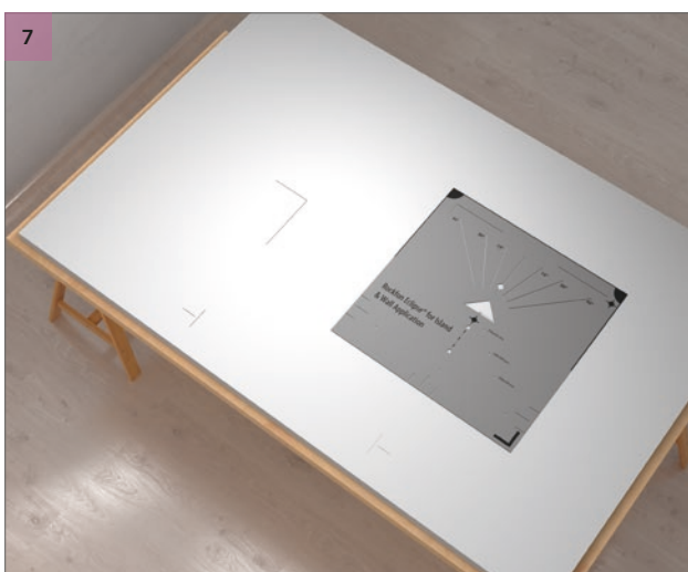
Markera linjerna där upphängningsbeslaget skall sitta. Detta skall göras på både höger och vänster sida av väggabsorbenten. Se fig. 7 - Resultat.
