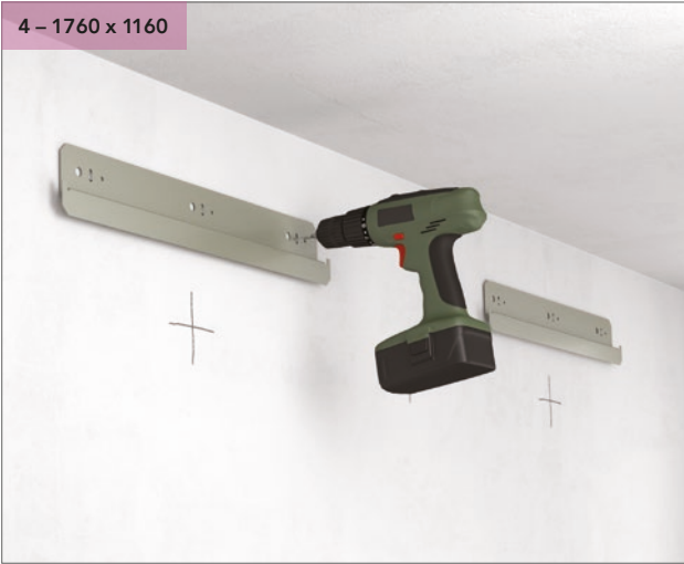
Borra hålen och fäst väggfästet.
